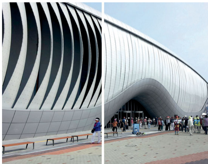
140 metrů dlouhá a 13 metrů vysoká fasáda Tematického pavilonu Expa 2012 byla vyrobena z Flectofinu a napodobuje otevírání a zavírání okvětních lístků. Má dlouhou životnost a je energeticky úsporná.
